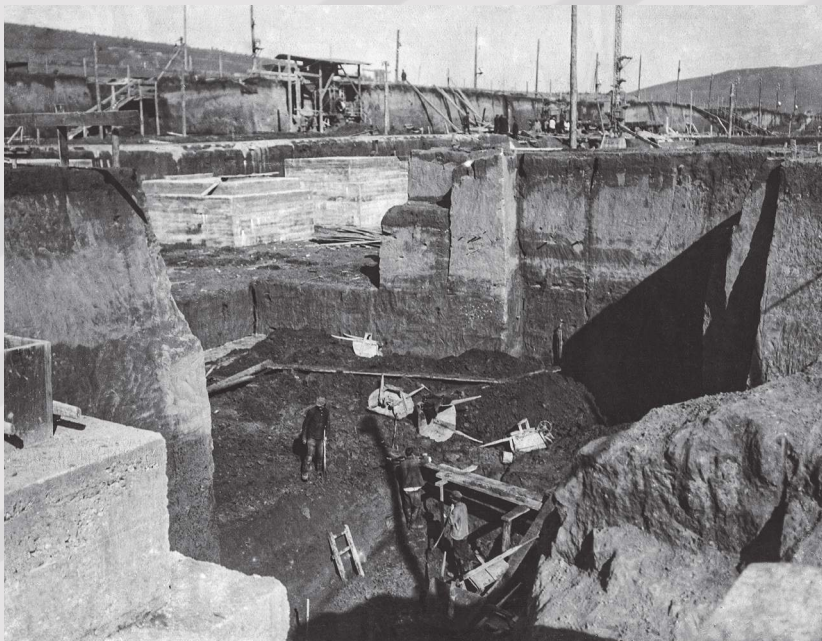
Рытье котлованов под мартеновский цех. 1931 г.
