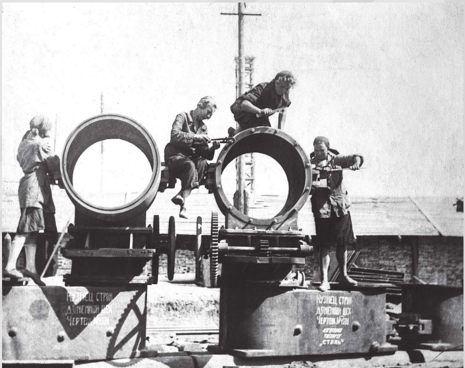
Женская бригада ведет монтаж газовых горелок на доменном цехе. 1931 г.
