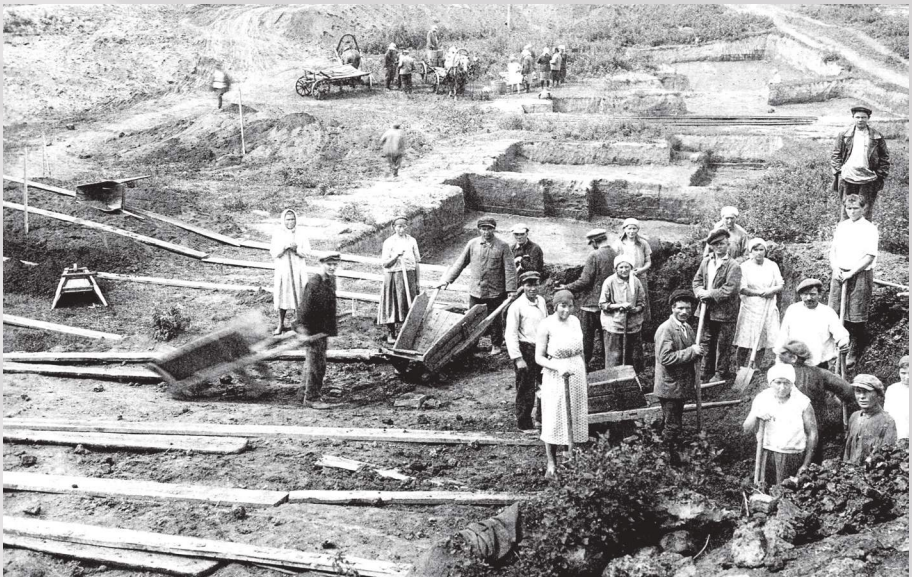
Земляные работы (женщины-землекопы). 1930 г.
