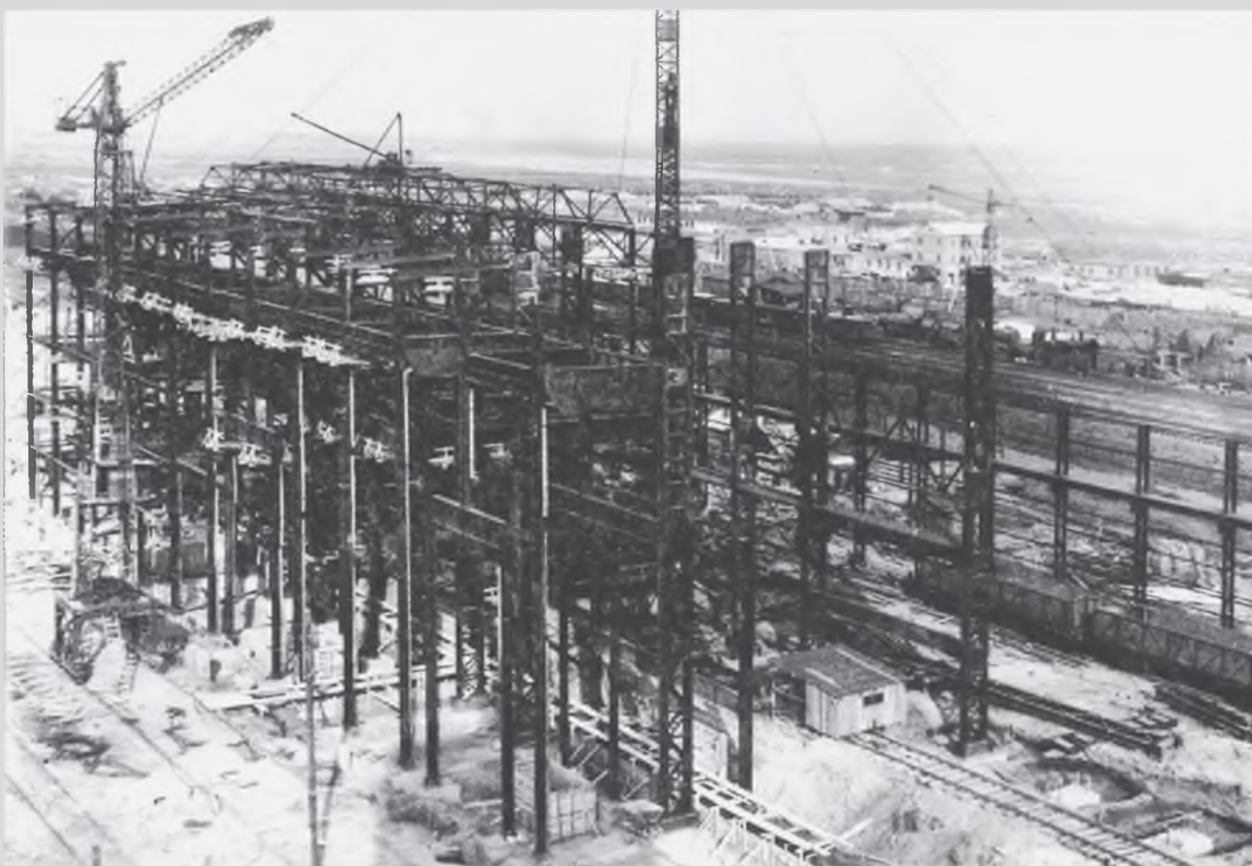
Ферросплавный завод. Строительство корпусов
